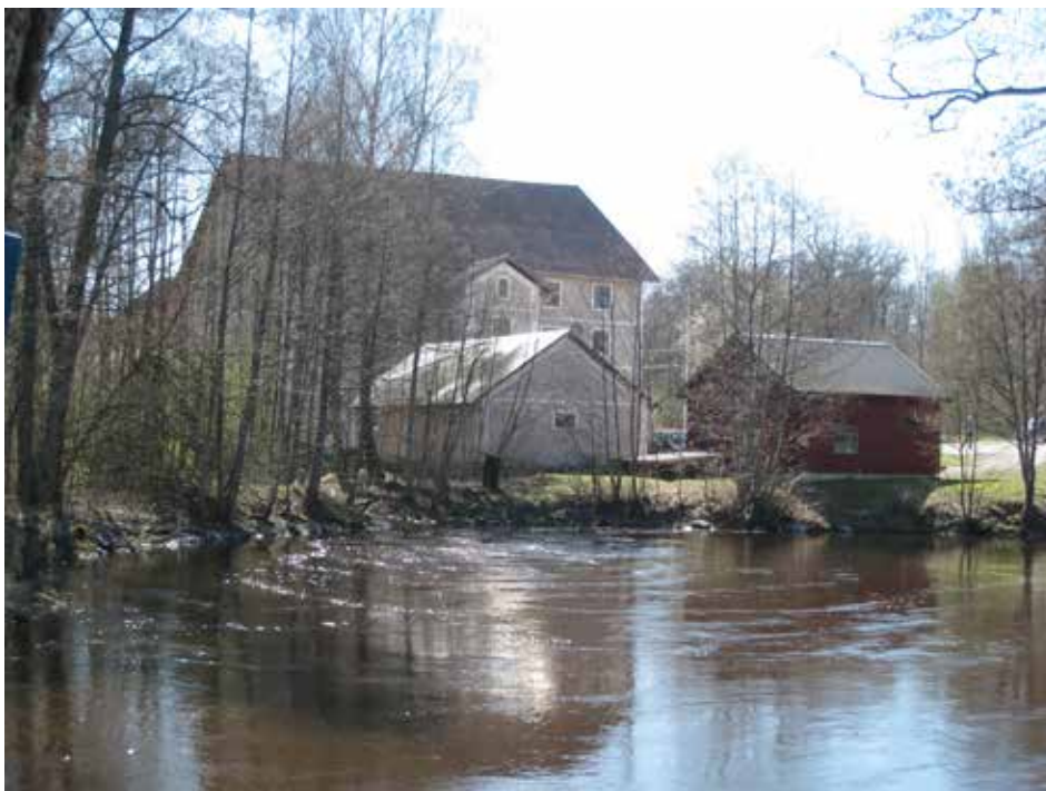
Den stora kvarnen från 1880-talet gav Karlslund möjlighet till mjölfällverkning i industriell skala. Intill kvarnen byggdes samtidigt ett stall. 1982 ersattes den gamla kraftstationens elproduktion av nya turbiner i en liten röd byggnad intill kvarnstallet. Utloppet från kanalen ger äns utvidgning starkt strömmande vatten. Udden tilläts under lång tid växa igen, men har återfått sin gamla ängs-karaktär sedan fotot togs. Foto Eva Fransson
