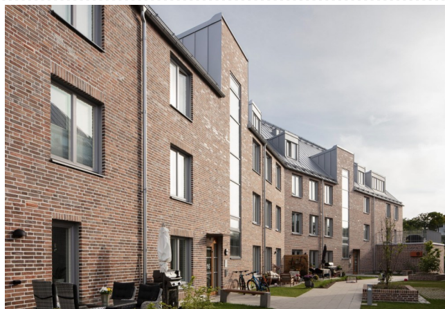
Välgestaltad tegelfasad och plåttak. Önneredsbodarna ritat av Semrén & Månsson. Foto: Semrén & Månsson/Kalle Sanner
