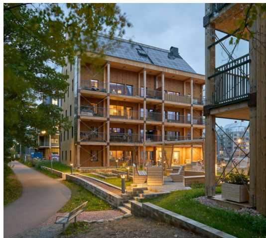
Generösa balkonger och innergård som skapar koppling mellan bostäderna och utemiljön. ETC hyreshus, arkitekt Kaminsky Arkitektur, Hans Eek. Foto: Kaminsky
